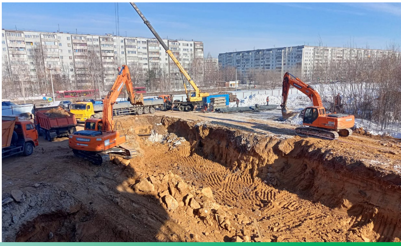
Начало строительства подземного паркинга ЖК «Мелодия»
